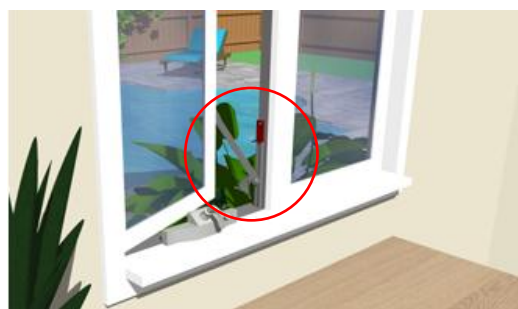
Figure 12 Limiteur d'ouverture pour fenêtre afin d'empêcher l'accès direct à l'intérieur de l'enceinte de la piscine
