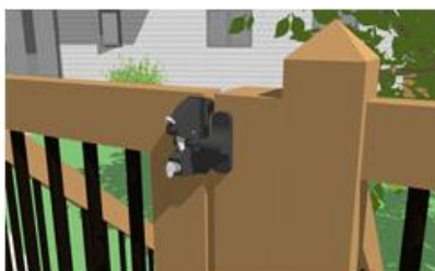
Figure 18 Exemple de loquet pouvant être installé du côté extérieur de l'enceinte, même lorsque celle-ci mesure moins de 1.5m de haut.
